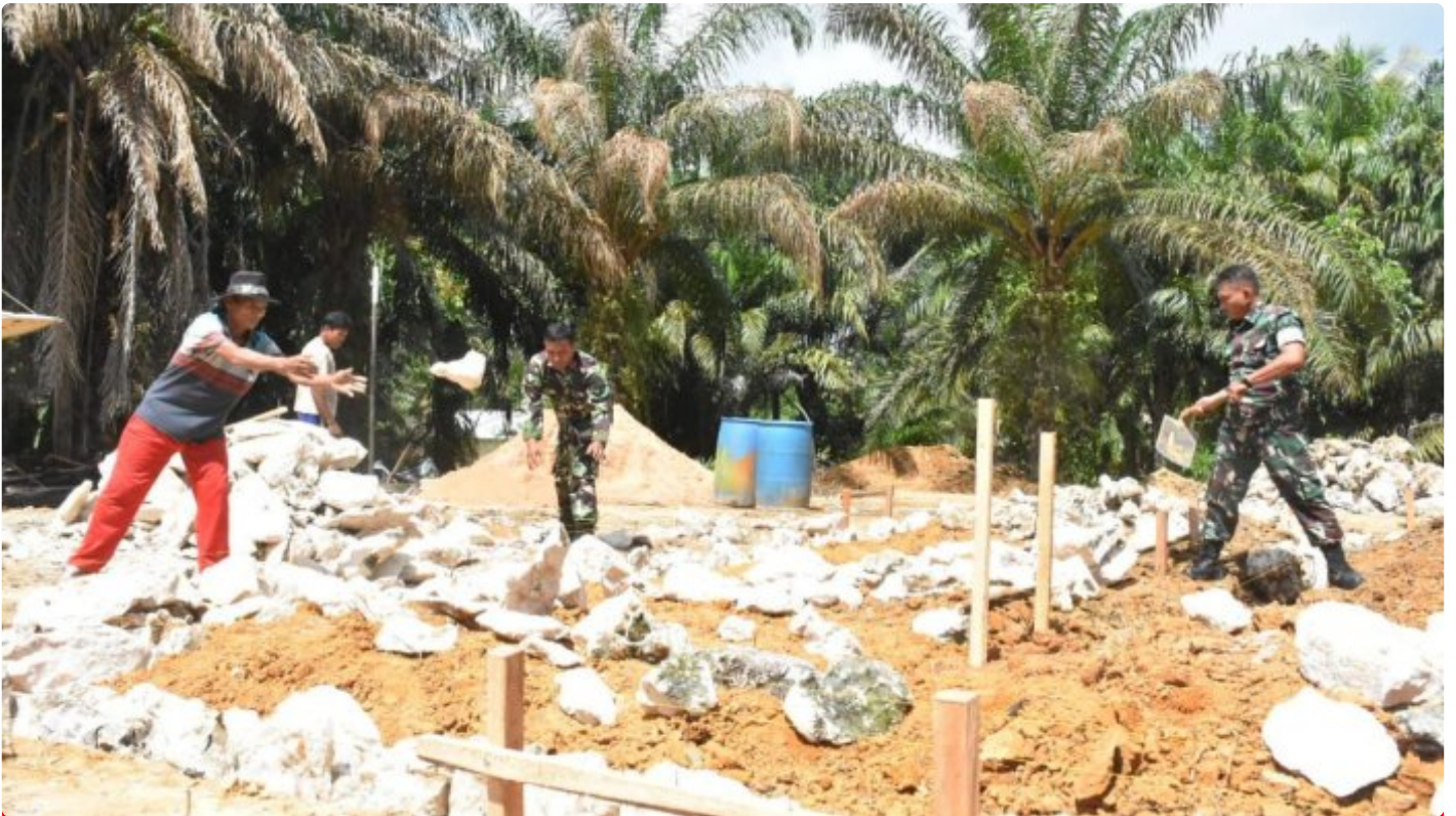
Satgas Pra TMMD Ke 116 Kodim 1004 Kotabaru Mulai Bedah Rumah Mbah Pasih
